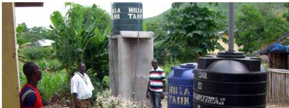
und drei große Plastiktanks errichtet. Einer davon steht auf einem kleinen Betonturm als Drucktank und gewinnt und sammelt jetzt während der Regenzeit das Wasser von oben. Weil aber die beiden Vorrattanks nicht sehr weit reichen werden, wird beschlossen, sie um zwei weitere zu ergänzen. Damit sollte man dann weit kommen. In der Trockenzeit kann man immer noch einen Tankwagen ordern, der die dann ausreichenden Tanks füllt. Gut 175 Auszubildende hat das Zentrum zur Zeit in den Handwerken
