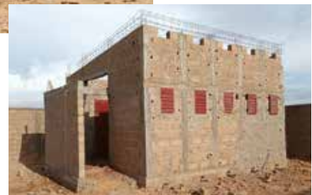
Gebäude für Sanitäranlagen steht
